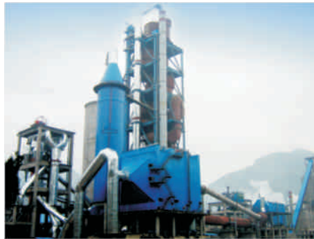
对耐火材料进行破碎
