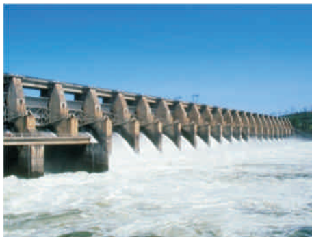
水电大坝建设
