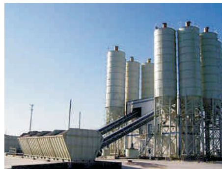
混凝土搅拌站
